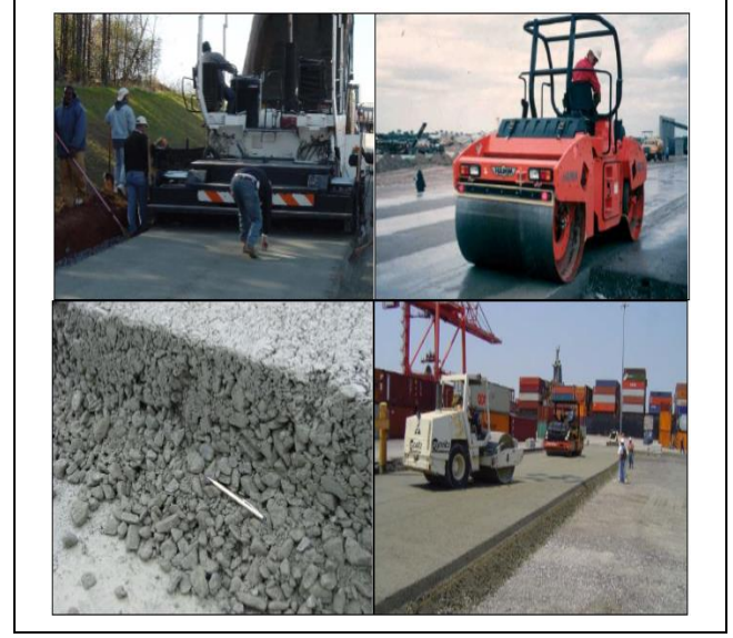
Şekil 4. SSB yöntemi ile yapılan yol örneği [17],[18].
