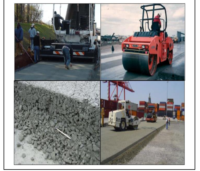
Şekil 4. SSB yöntemi ile yapılan yol örneği [17],[18].
