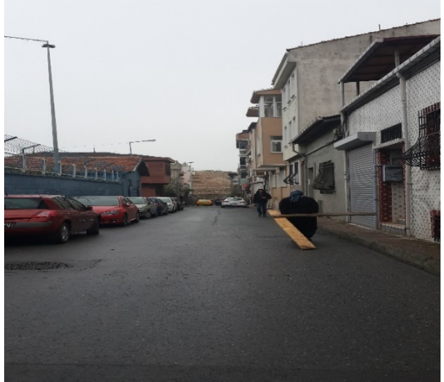
Fotoğraf 13. Asfalt Malzeme ile Yenileme
