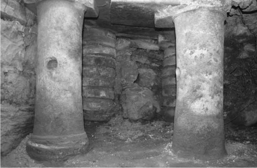
Levha 8. Tepidarium Hypocaust Sistemi Pilaeleri (Parion Kazı Arşivi).
