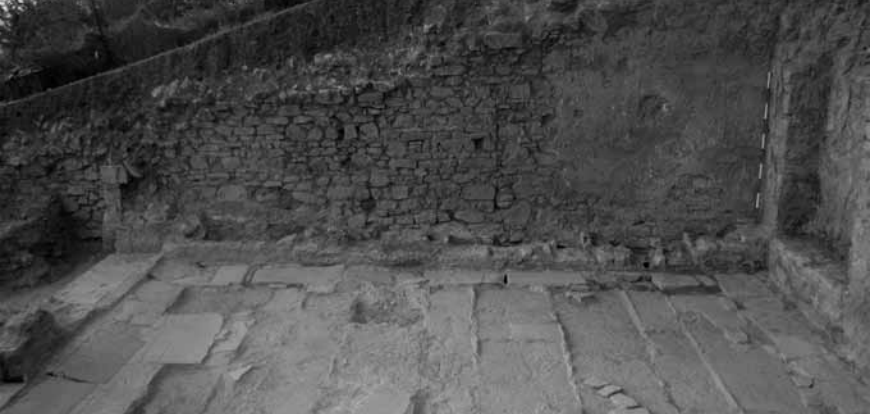
Levha 4. Apoditerium Kuzey Duvarındaki Oturma Sekisi (Parion Kazı Arşivi).
