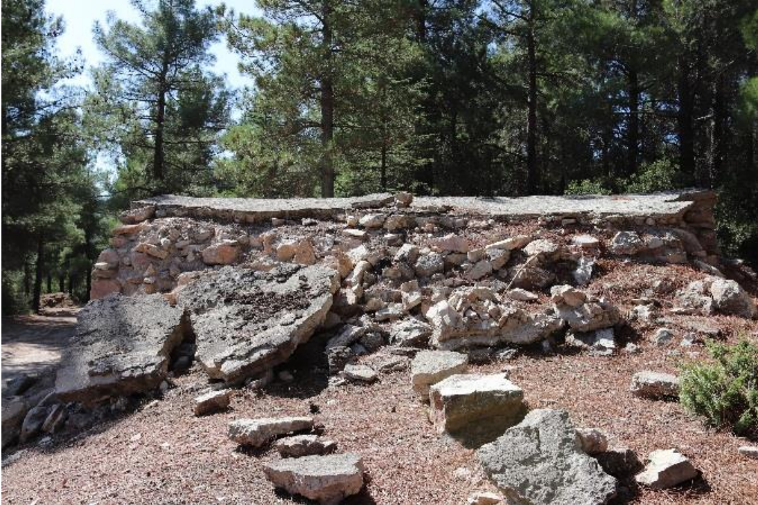
Fotoğraf 8: Doğu cephe duvarı
