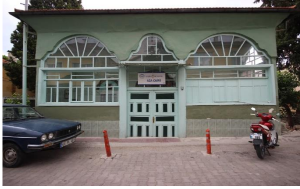
Resim-2: Hacı Mehmed Ağa Camii Kuzey Cephe Görünümü.
