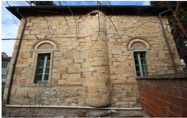
Resim-4: Hacı Mehmed Ağa Camii Güney Cephe Görünümü.
