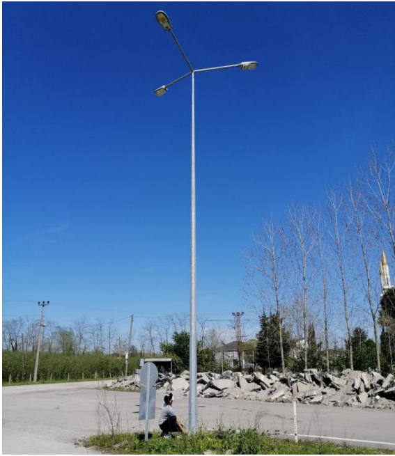
Şekil 3. Havaalanına 1,5 kilometre uzaklıktaki elektrik direğinin lazermetre ile yükseklik ölçümü
