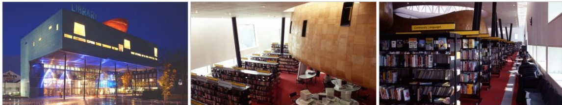
Şekil 3. Peckham Kütüphanesinin dış ve iç mekân fotoğrafları (Archello, t.y.)
