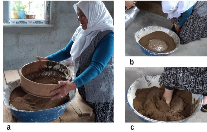
Fotoğraf 4: a). Tıkk/tıkkalık toprağın elenmesi, b-c). Toprağı su eklenmesi ve ayakla yoğurulması
