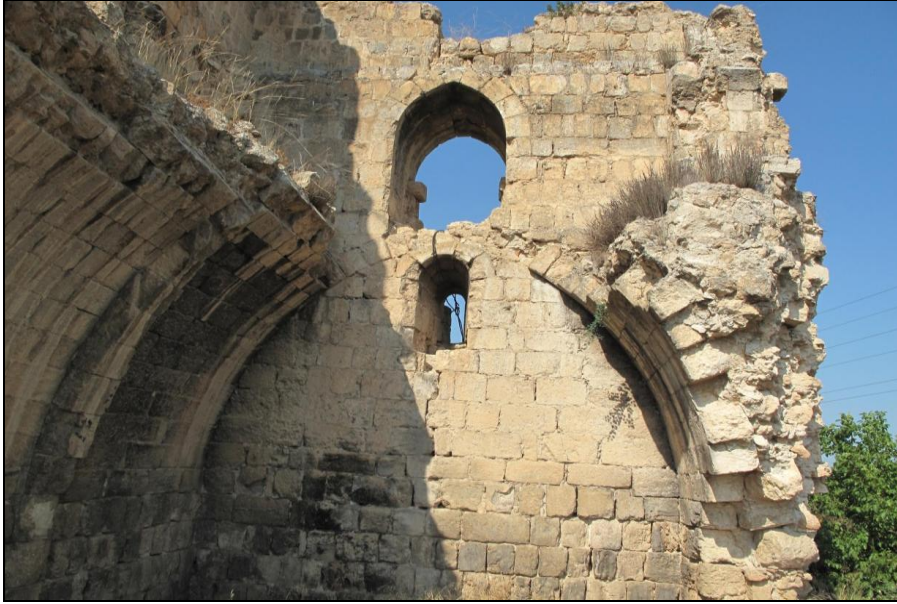
Resim:8- Doęu Duvarında Görülen Pencereleler.
