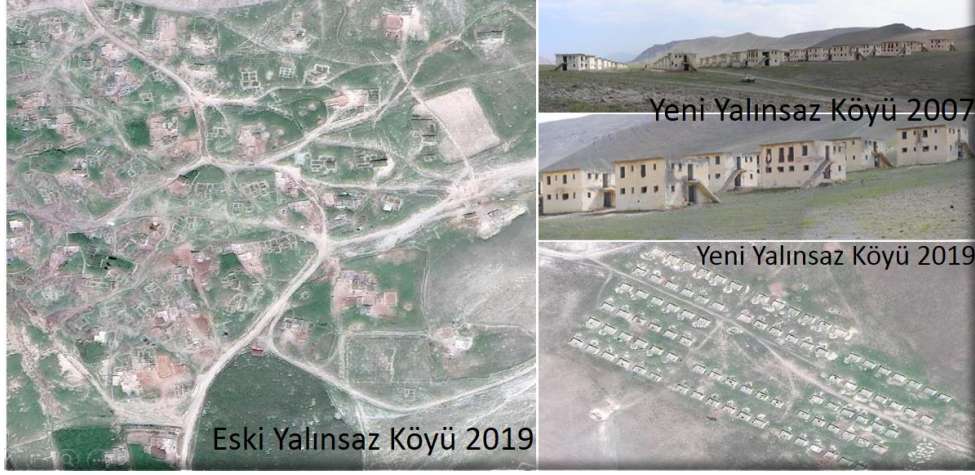
Şekil 4: Afet riskinin ortadan kaldırılmadığı yerleşim alanları: Yalinsaz Köyü (Tercan 2019)
