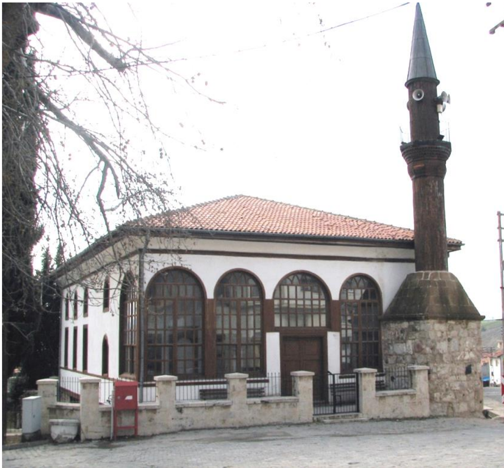
Fotoğraf 1-3. İsabey Camii. Kuzeybatı, Doğu ve Kuzey Cephe (09.02.2019).
