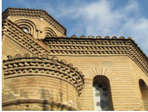
G.15.Panagia ton Khalkeon Kilisesi, doğu cephe, detay: köpek dişi frizler (Foto. yazara ait, 2018).
