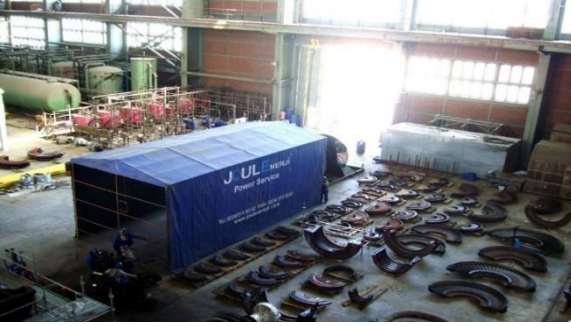
Şekil 1. Buhar türbini c tipi bakım çalışmaları.
