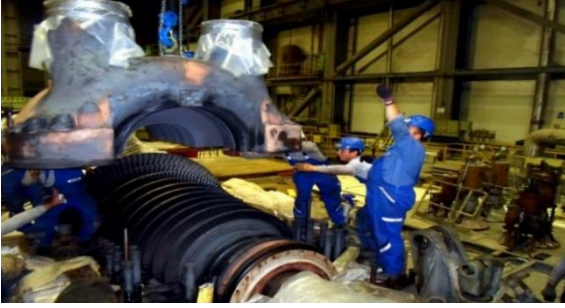
Şekil 2. Üst gövde kapağının demontajı.
