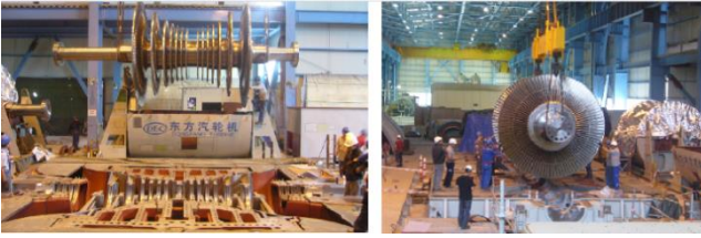
Şekil 5. Rotor montaj çalışmaları.
