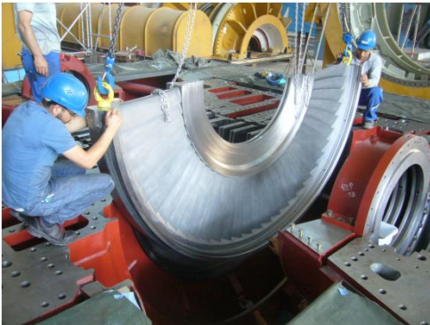
Şekil 3. Diyaframların montajı.
