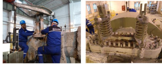
Şekil 11. Kontrol vanası bakım çalışmaları.
