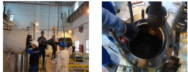
Şekil 9. Trip vanalarının demontajı ve sızdırmazlık elemanlarının değişimi.
