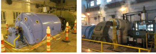
Şekil 10. Buhar türbini devreye alma çalışmaları.
