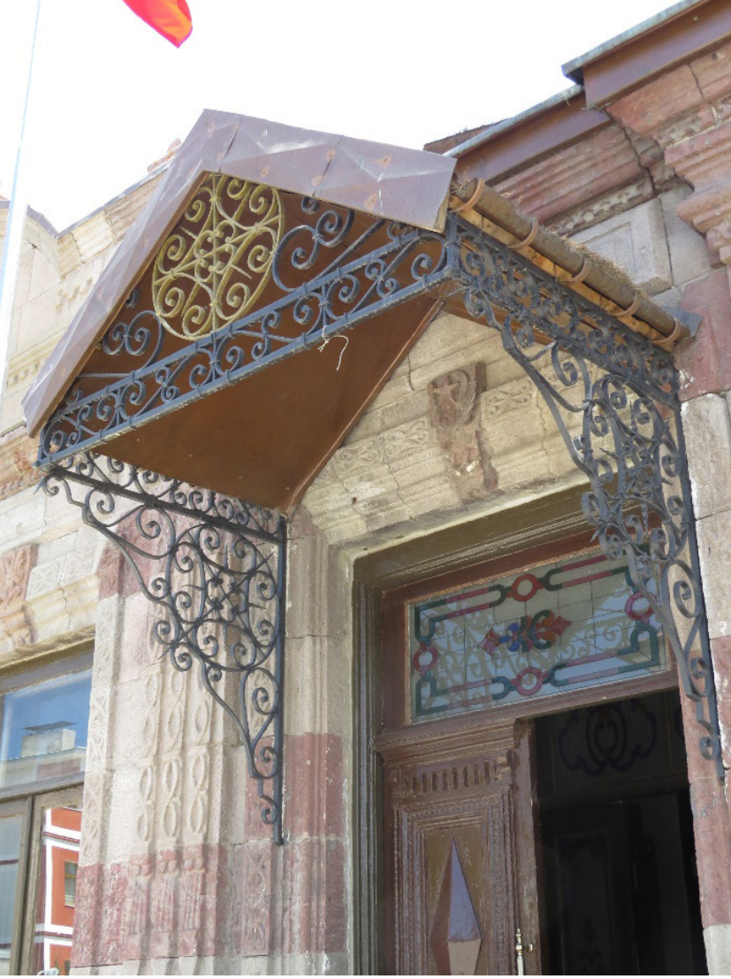
Resim 28- Hamşioğlu Konağı ferforje kapı sundurması.
