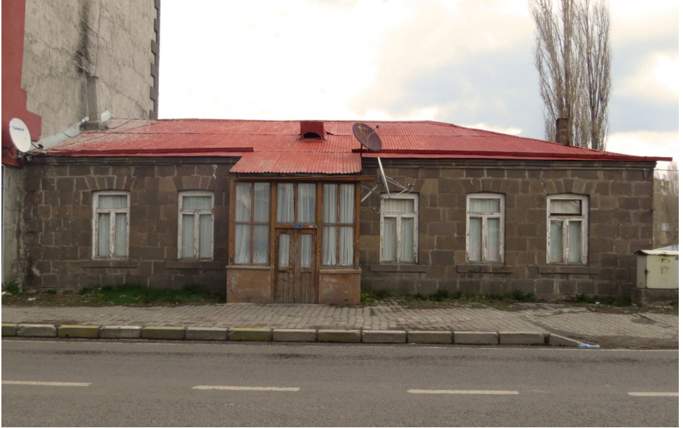
Resim 39- İsmet Avşar Evi'nin güney cepheden genel görünümü.
