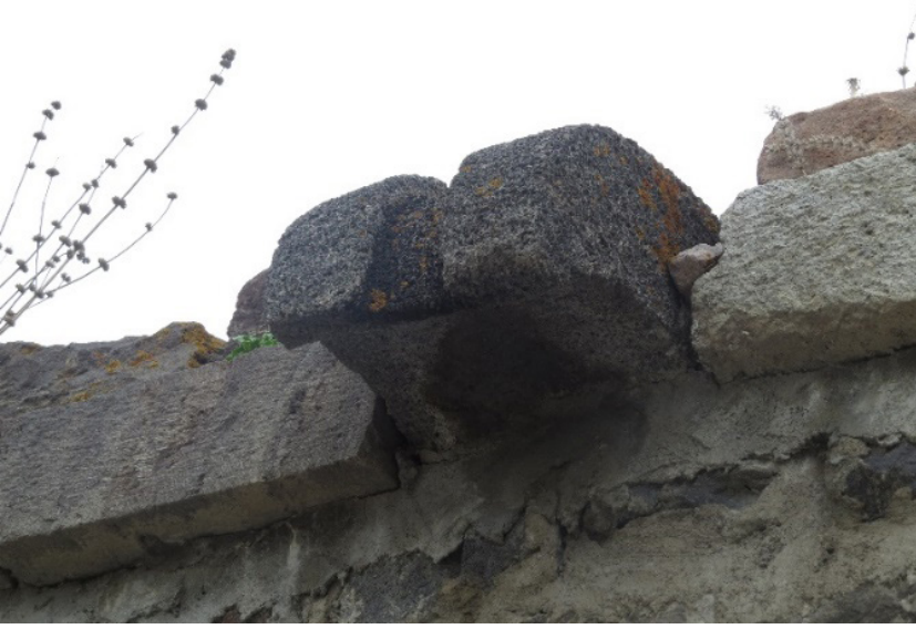
Resim 36- Kara Kadiođlu Evi ön cephe çatı saçağında yer alan çörtlen.
