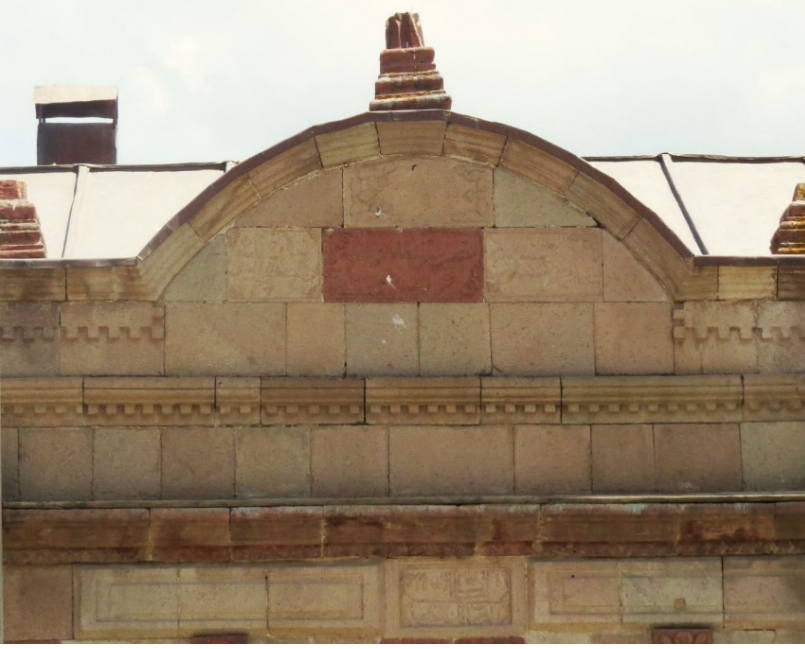
Resim 29- Hamşioğlu Konağı kitâbe panoları.
