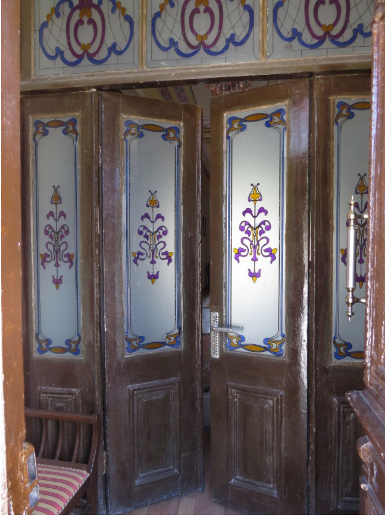
Resim 26- Hamşioğlu Konağı rüzgârlık kapısındaki vitray cam uygulaması.
