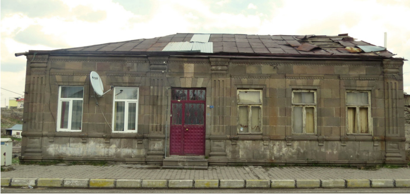
Resim 37- Abdullah Öđüt Evi'ndeki güney cephe genel görünüm.
