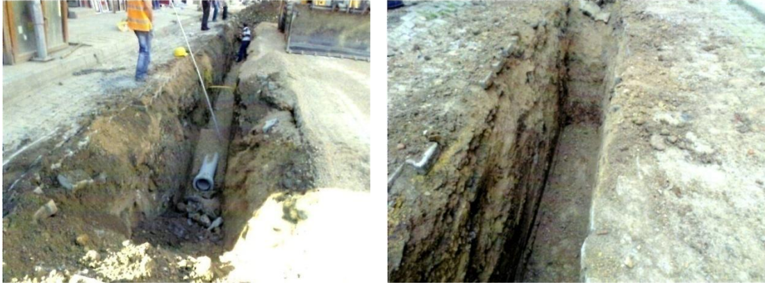
Res. 17-18: Cumhuriyet Mahallesi Kanalizasyon Alt Yapı Çalışmasından Görüntüler
