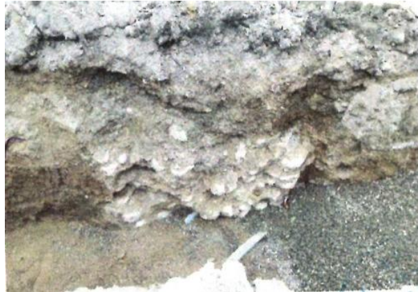
Res. 57: Tahrip edilen temel kalıntıları
