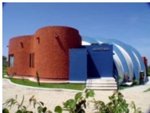
Fig. No. 24 Main facade.. UMAR.
