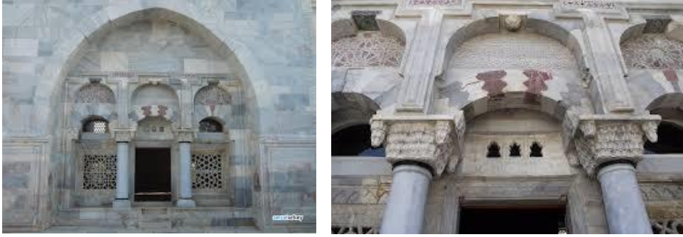
Şekil 2. İlyasbey Camisi'nin kuzey cephesine ait görüntüler
