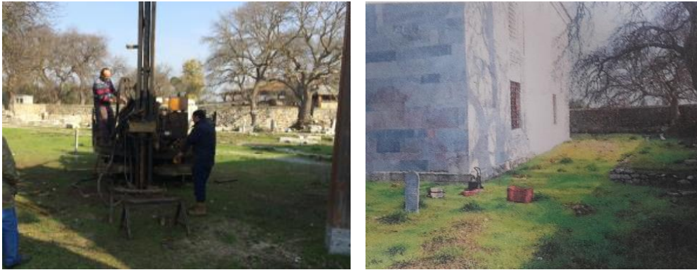
Şekil 5. İlyasbey Camisi'nin bulunduğu bölgede gerçekleştirilen sondaj incelemelerine ait görüntüler
