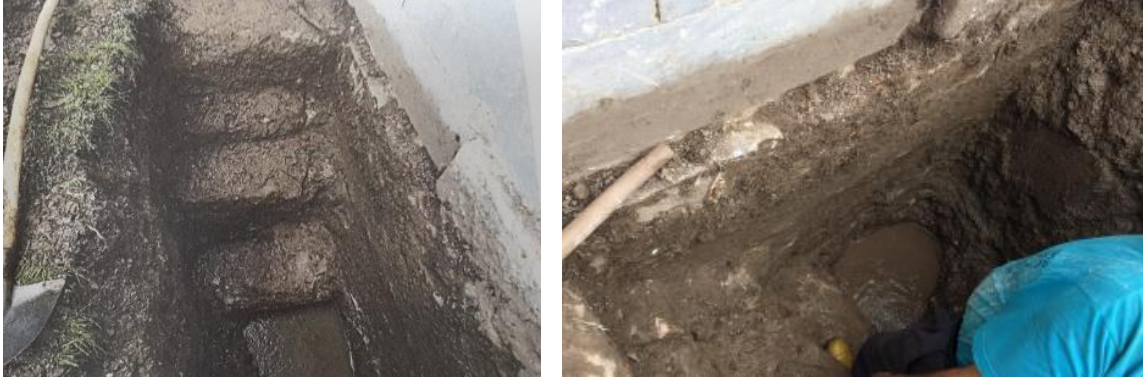
Şekil 6. İlyasbey Camisi'nin bulunduğu bölgede temel gözlem çukuru incelemesine ait görüntüler
