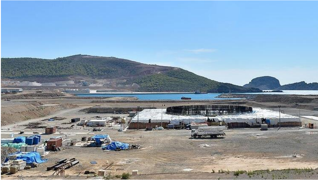
Şekil 2. Akkuyu N kleer G c Santrali İnşaatı ( https://www.hurriyet.com.tr/ )
