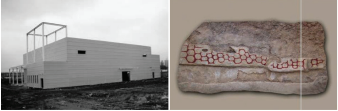
Şekil 9. 2010 Şangay Fuarı Türkiye Pavyonu Mevcut Yapı & Duvar Resmi
