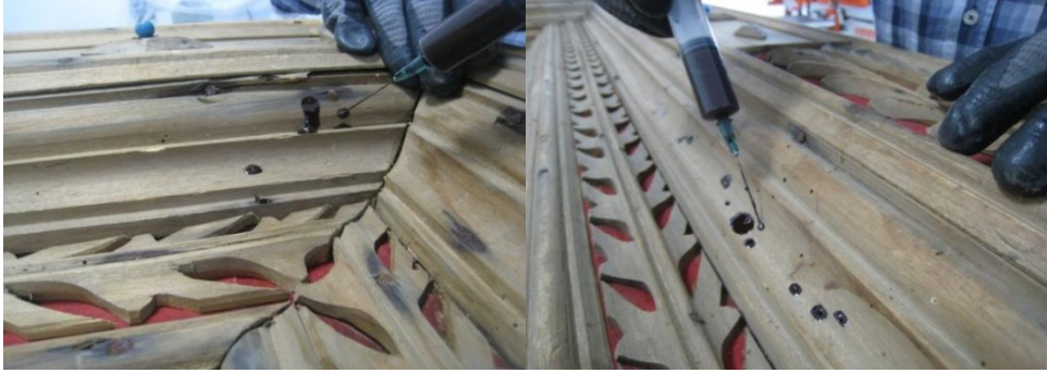
Resim 8. Ahşap koruyucunun deliklere enjekte edilmesi (2012)
