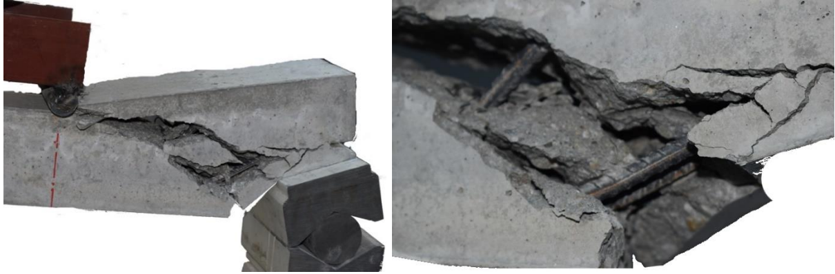
Şekil 5. N1 numunesi göçme hasarı
