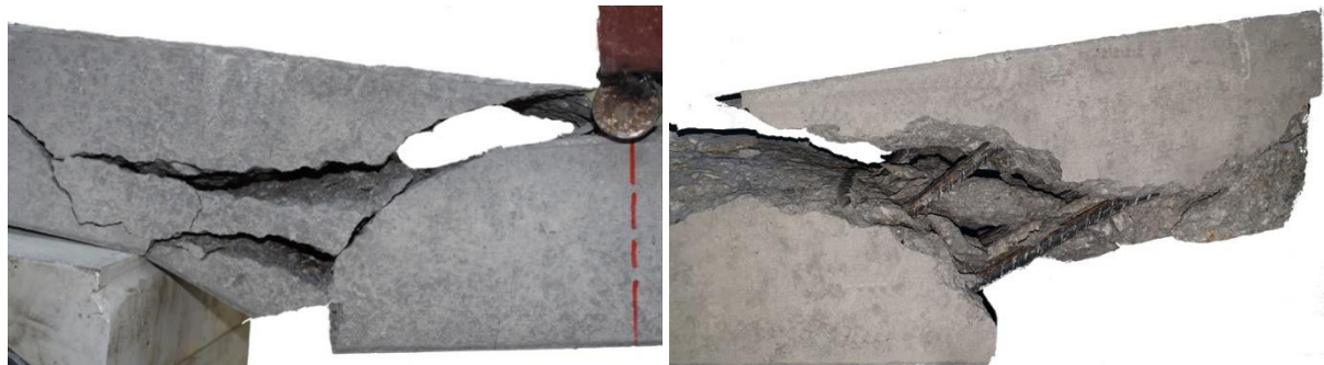
Şekil 6. N2 numunesi göçme hasarı
