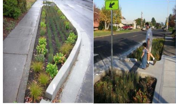
Şekil 3.8 (a) ve (b) Portland, Oregon'daki Kuzeydoğu Fremont ve 131st Green Street kaldırım genişletmesi.
