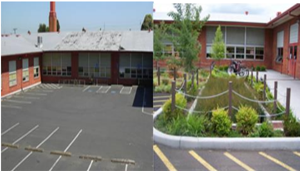
Şekil 3.6 (a) ve (b). Mount Tabor Middle School'un geçirimsiz yüzeye sahip bahçesinin ve otoparkının yağmur bahçesine dönüştürülmesi ( Asla, 2019)
