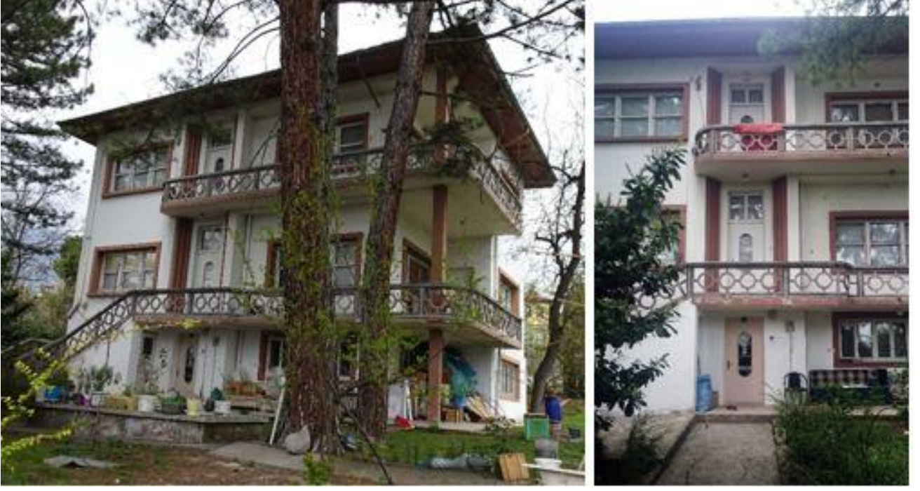
Şekil 11-12: Ganioglu Konağı Güney Cephesi ve Giriş Kapıları
