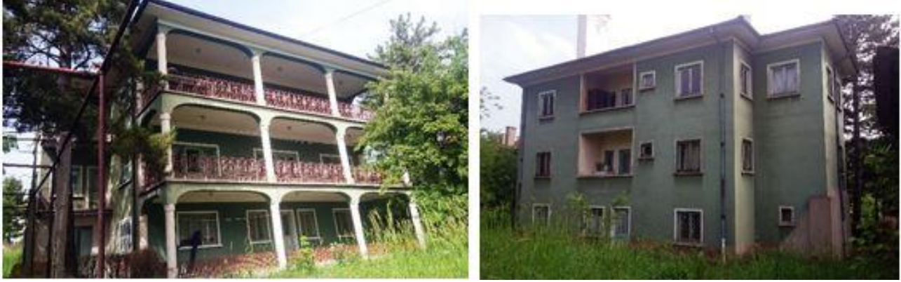
Şekil 15-16: Kalafatoğlu Konağı Güney Cephesi (Solda), Kuzey Cephesi (Sağda)
