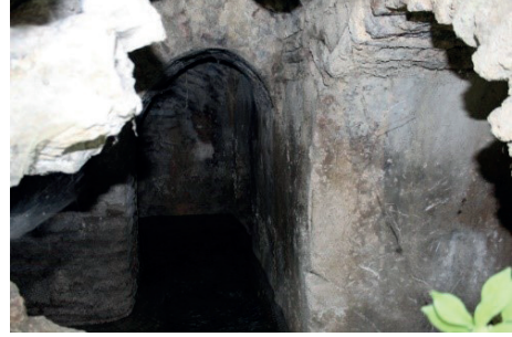
F. 39: Çamaşırhane, su deposunun içinden görünüm
