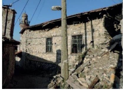
F. 28: Minareli Cami, batı cepheye bakış
