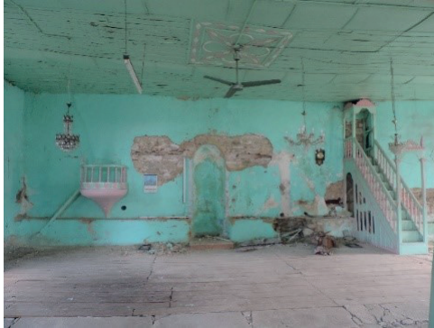
F. 32: Minareli Cami, güney duvarına bakış
