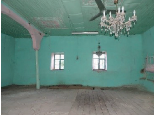
F. 31: Minareli Cami, doğu duvarına bakış
