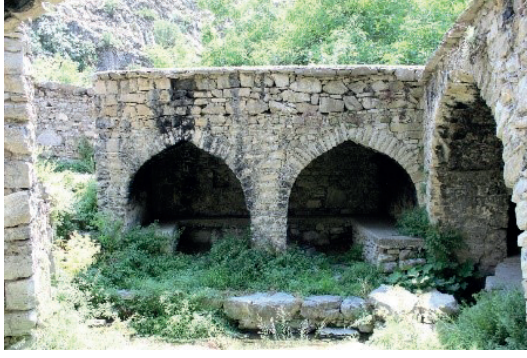
F. 35: Çamaşırhane, avludan batı eyvanına bakış
