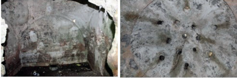
F.3: Hamamın sıcaklık bölümü ve sıcaklık bölümünün kubbesi (2019)
