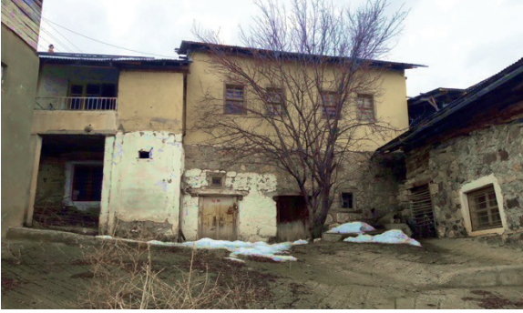
Resim 13: Hacı Osman Ayık evi güney cepheden dış görünüm (Fotoğraf: Arif Çoruh).
