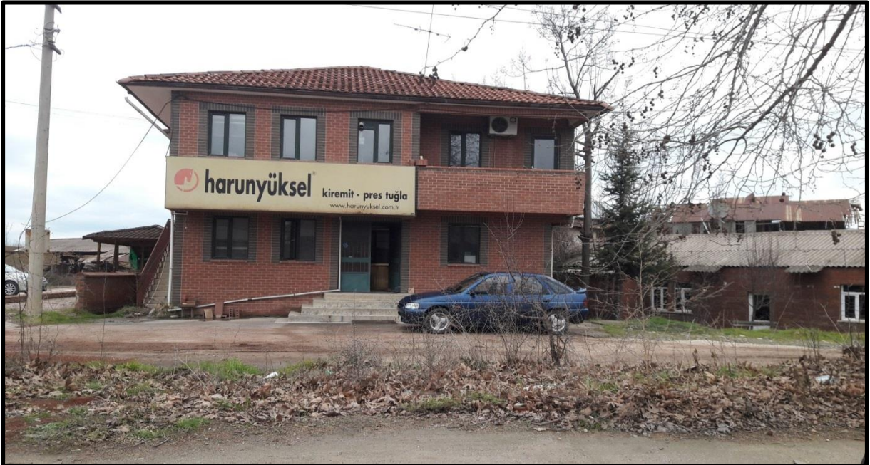
Şekil 7. Şehirdeki Toprağa dayalı sanayinin ilk örneği Harun Yüksel Tuğla Fabrikası (27.01.2018).
