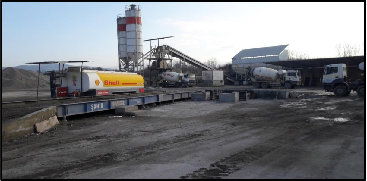
Şekil 15. Kayalar Hazır Beton Tesisleri (08.01.2018).
