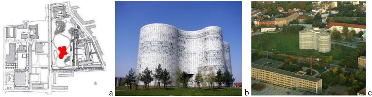
Şekil 18. Brandenburg Teknik Üniversitesi Kütüphanesi Konum Planı (a) ve Genel Görünümü (b, c) (Url-12; Degkwitz, 2010).
