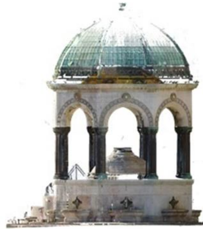
Şekil 6. Alman Çeşmesi'ne ilişkin nokta bulutu görseli
