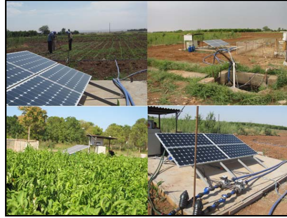
Şekil 2. PV-Damla sulama sistemi elemanları
