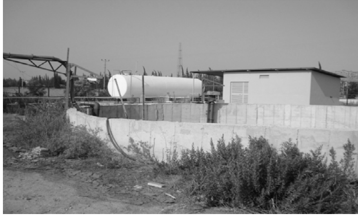
Şekil 5: Son depo, gaz deposu ve kojenerasyon binası
