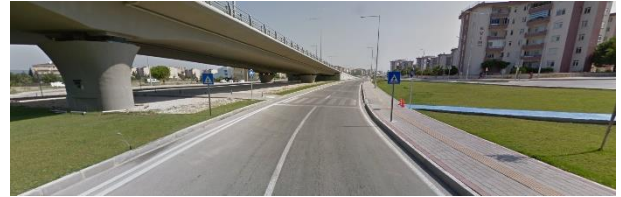
Şekil 11. Kuzeydoğu Yönündeki Yaya Geçidi (Google Earth, 2020)
