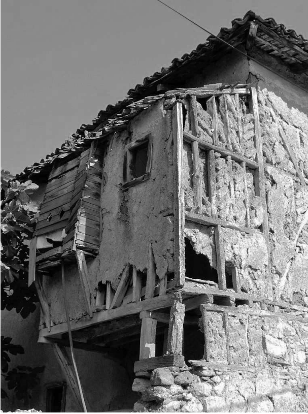
Fotoğraf 3. 112 Ada 20 Parseldeki Evin Kuzey Cephesindeki Harap Haldeki Tuvalet Çıkması (Fotoğraf: Selma Tunalı)
