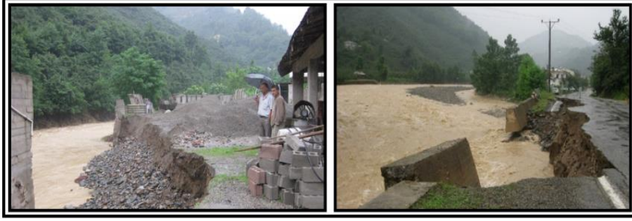
Fotoğraf 2: Batlama Çayı, 2009 yılında gerçekleşen selde, kıyı ile iç kesimler arasında ulaşımı sağlayan karayoluna büyük zararlar vermiştir (Fotoğraf, DSİ Anonim).
