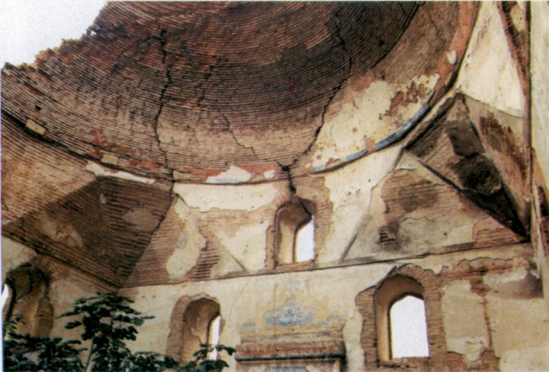
Res. 8. Edirne- Karaağaç Timurtaş Köyü Timurtaş Paşa Camisi'nde kubbeye geçiş elemanları ve kubbenin görünümü
