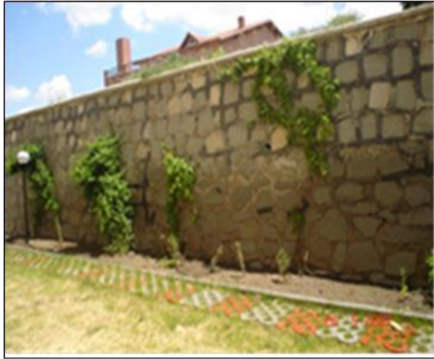
Şekil 6. Duvar önü aydınlatma elemanı
