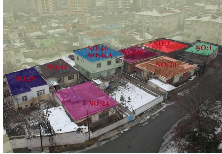
Fotoğraf 2. Küçükali Mahallesi 1721 Ada'nın Bir Bölümünün Şekil 4'de İmar Planı Verilen Konutların Hava Görüntüsü [63].
