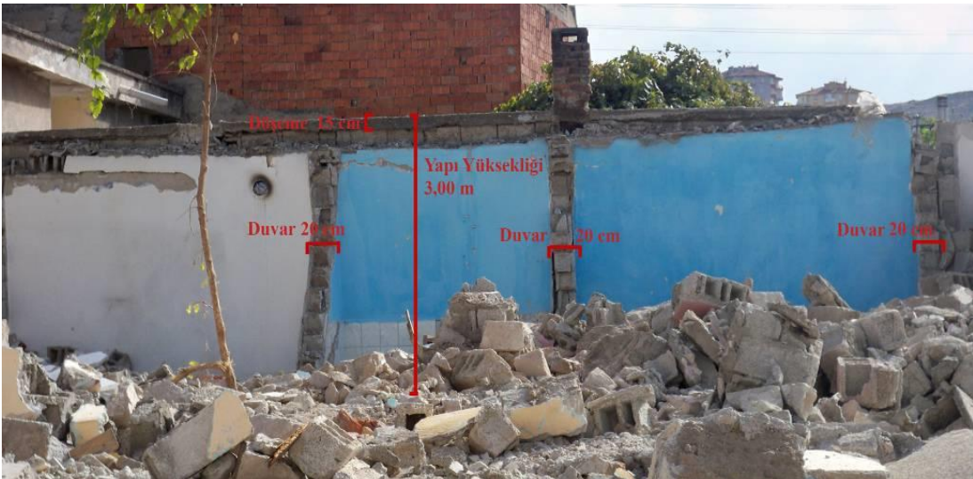
Fotoğraf 4. Küçükali'de 2. Etap Yıkım Çalışmaları [64].
