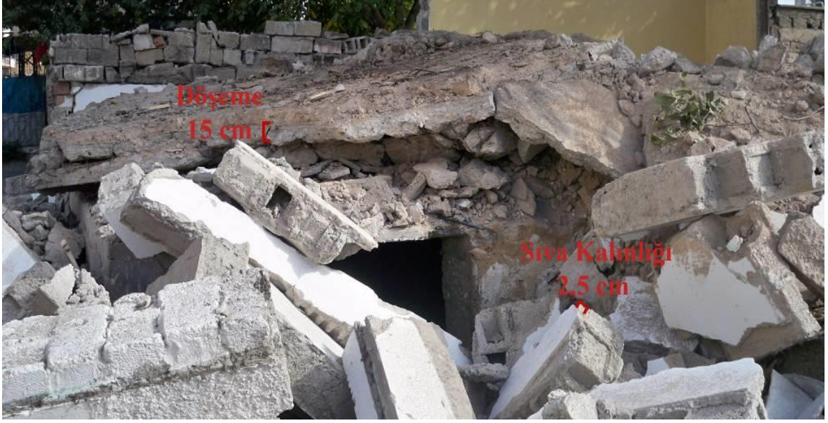
Fotoğraf 3. Küçükali'de 2. Etap Yıkım Çalışmaları [64].
