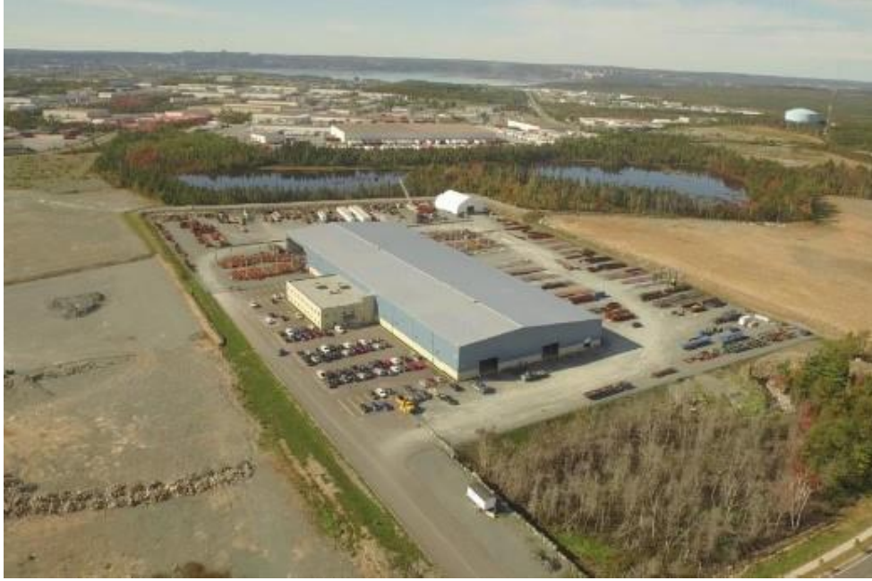
Şekil 1. Burnside endüstriyel parkı (Cherubini Bridges & Structures, 2020)
