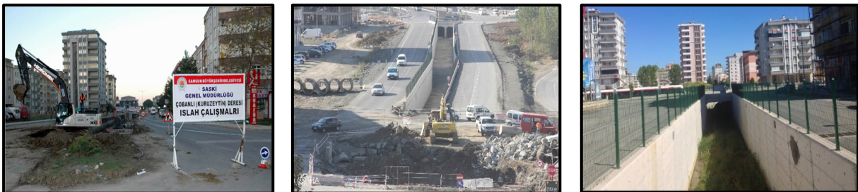
Foto 14-15-16. Samsun Büyükşehir Belediyesi tarafından selleri önlemek amacıyla yapılan dere ıslahı projelerinden biri olan Çobanlı Deresi. Bu örnekte olduğu gibi kent içindeki dereler üstleri açılarak önce görünür hale getirildi, ardından kanal içine alınarak kontrollü akış sağlandı.
