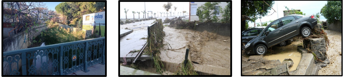
Foto 11-12-13. Değirmendere'nin kanal içine alınmış hali ve 6 Ağustos 2012'de sel ve taşkın zamanı ve sonrasında ortaya çıkan görünüm (Samsun Büyükşehir Belediyesi Arşivi).
