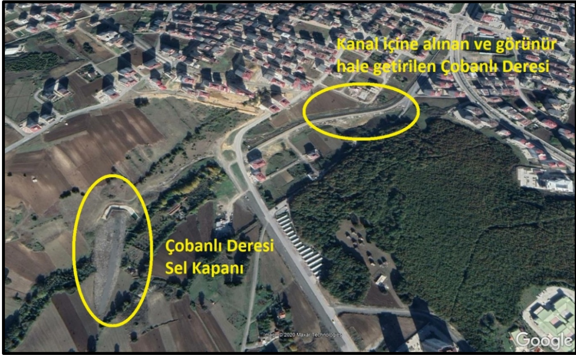
Foto 19. (Google Earth üzerinden) Çobanlı deresi; yukarı kesimde açık yüzeyde akışı, ortada önüne inşa edilen sel kapanı, aşağı kesimde şehir içine / kentsel alana giriş yaptığı kesimden itibaren kanal içine alınmış ve görünür kılınmış olarak denize ulaşması.
