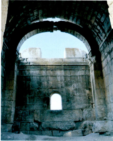
Resim 10 -Yapının Kuzeydoğu Duvarı İç Yüzü
