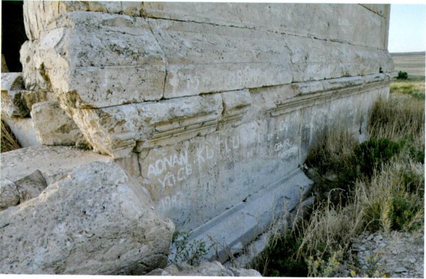
Resim 2 - Güneydoğu Cephesindeki Podyumun Görünümü
