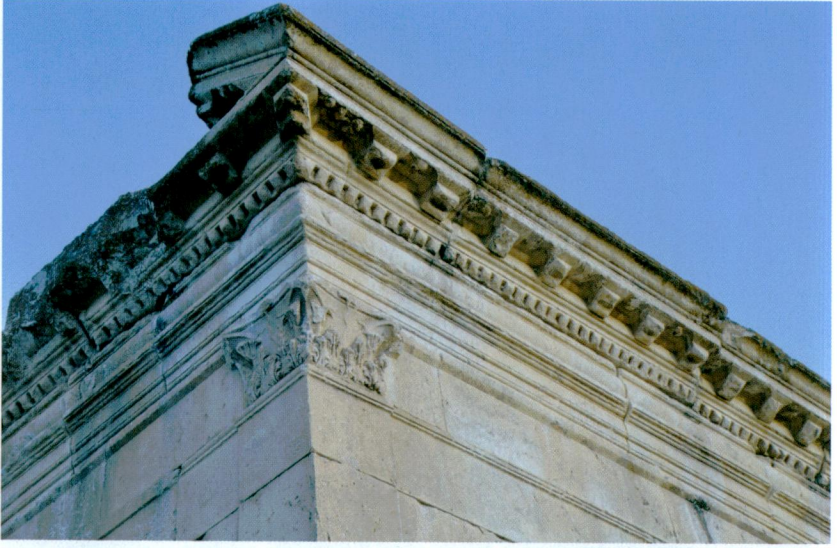
Resim 5 - Kuzey Köşe Detayı
