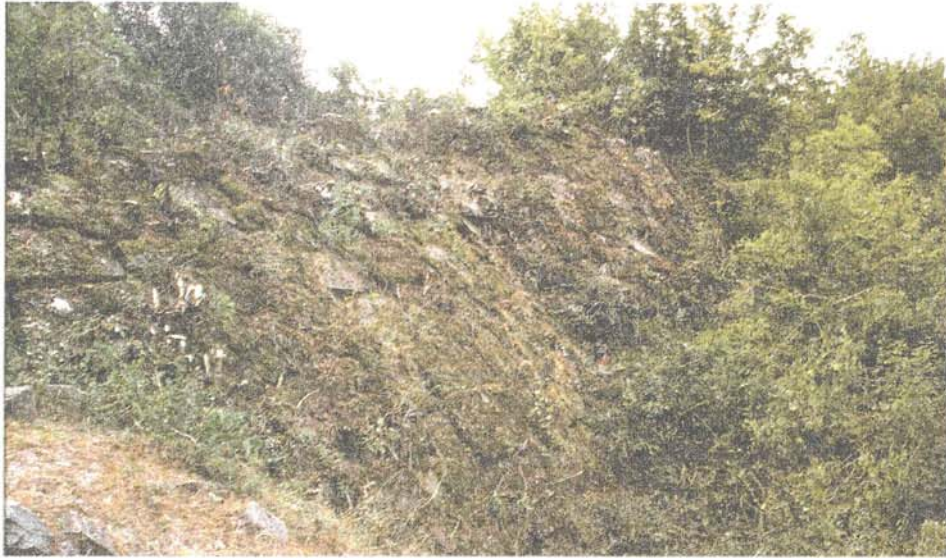
Res. 3: Akalan, eğimli sur duvarları.
