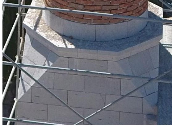
Foto. 28: Tuğlaya Geçişi Sağlayan Taş Bilezik
