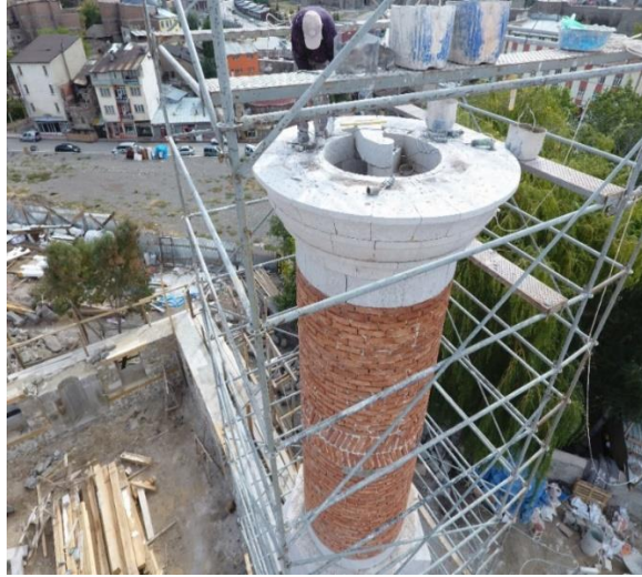
Foto. 33: Şerefe Bölümünün İnşası ve Balkon Genişliği
