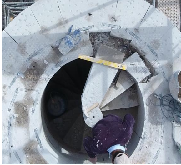
Foto. 32: Merdivenlerde Kullanılan Taşlar ve Yerleştiriliş Biçimi Şerefe balkonunun boşluğu ne kadar olmalı?
