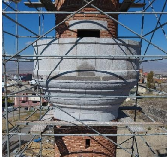
Foto. 35: Dramazon Taşının Yerleştirilmiş Hali
