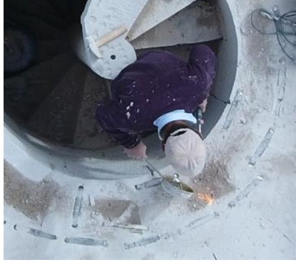
Foto. 31: Eritilen Kurşunun Deliklere Dökülmesi
