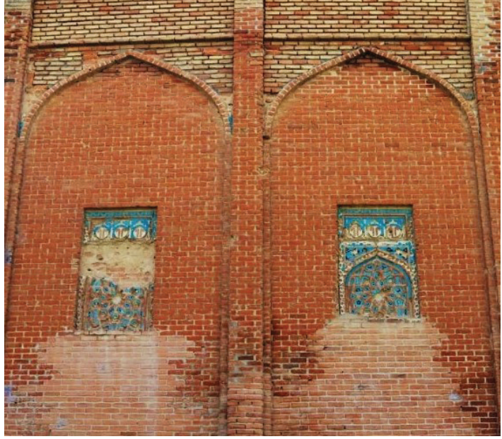
Fotoğraf 11: Emir Şemseddin Karasungur Kümbeti'nin batı cephesindeki çevgân sopası renklerinin düzeni
