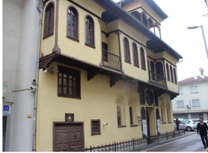
Resim3. İstanbulluoğlu Konağı ön cephe görüntüsü Merkez, Malatya
