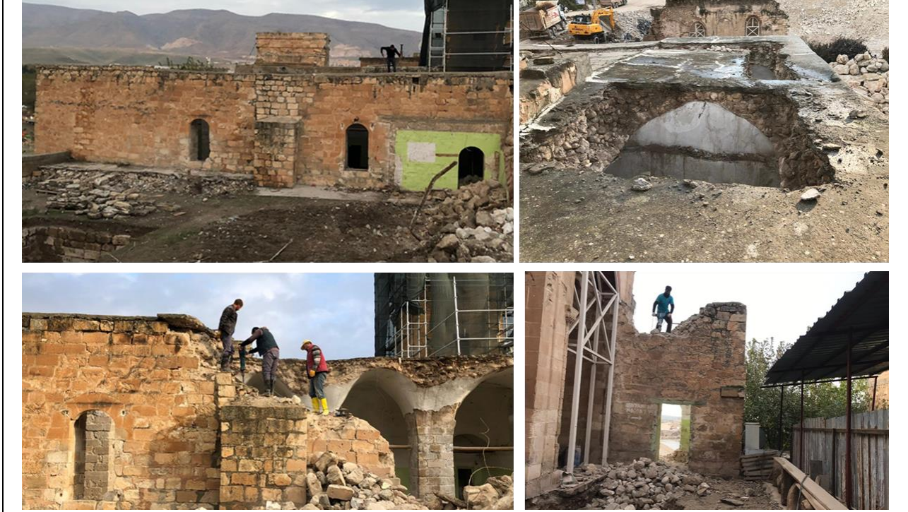
Resim 4. Hasankeyf Er Rızk Camiinin Taşıma Öncesi Niteliksiz Eklerin Kaldırılması Çalışmaları (ER-BU İnşaat Tic. Aş. arşivi) .
