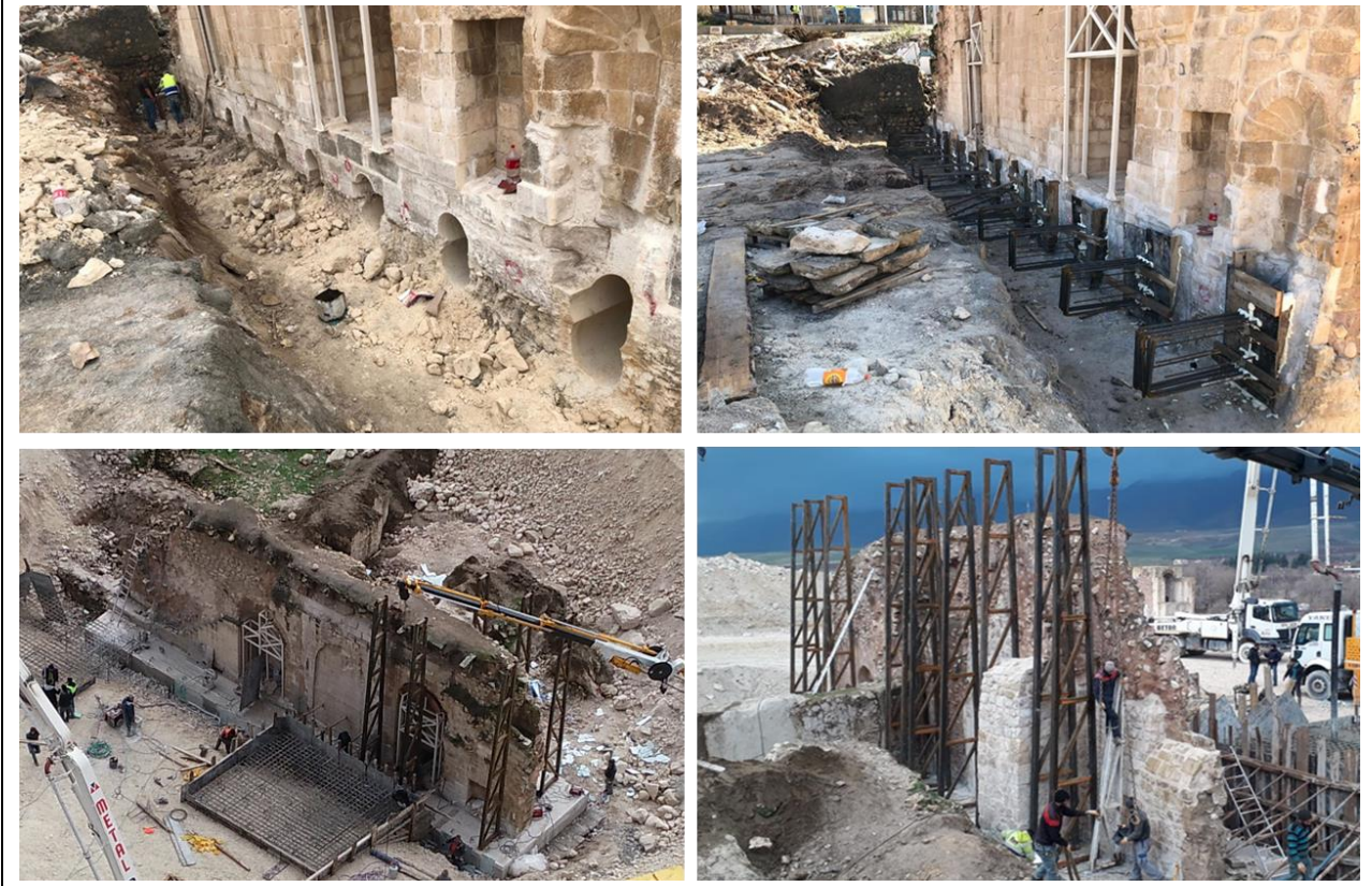
Resim 5. Hasankeyf Er Rızk Camii Harim Mekanı Kuzey Cephe Duvarının 4 Yapı Bloğuna Ayırılarak Taşıma çalışmaları .
