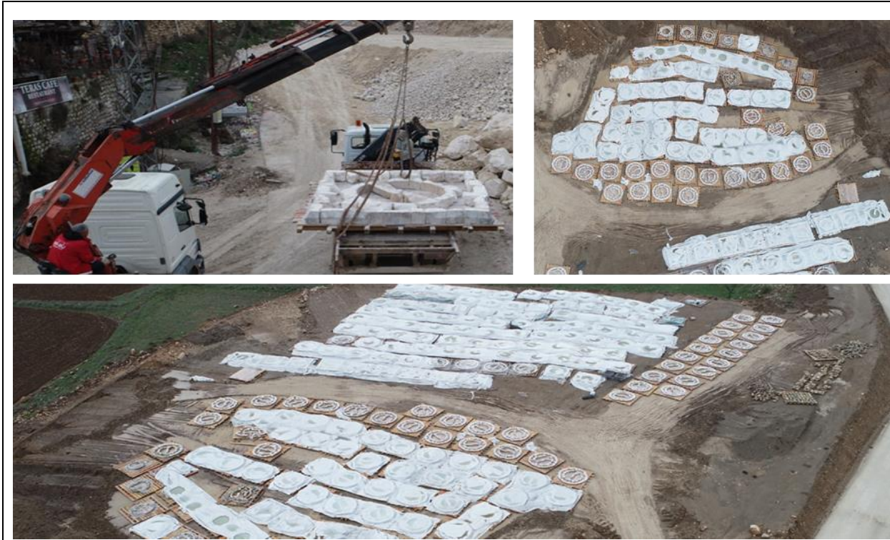
Resim 8. Hasankeyf Er Rızk Camii Minaresinin Sökümü Yapılan Birim Yapı Elemanlarının Taşıyıcı Platformların Üzerine Alınarak Depo Alanına Taşınması.
