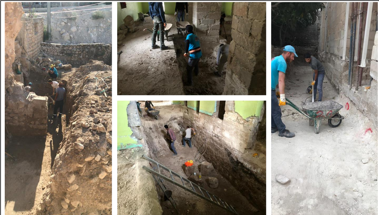
Resim 3. Hasankeyf Er Rızk Camiinin Temellerinin Arkeolojik Kazı Çalışmasıyla Ortaya Çıkarılması (ER-BU İnşaat Tic. Aş. arşivi).
