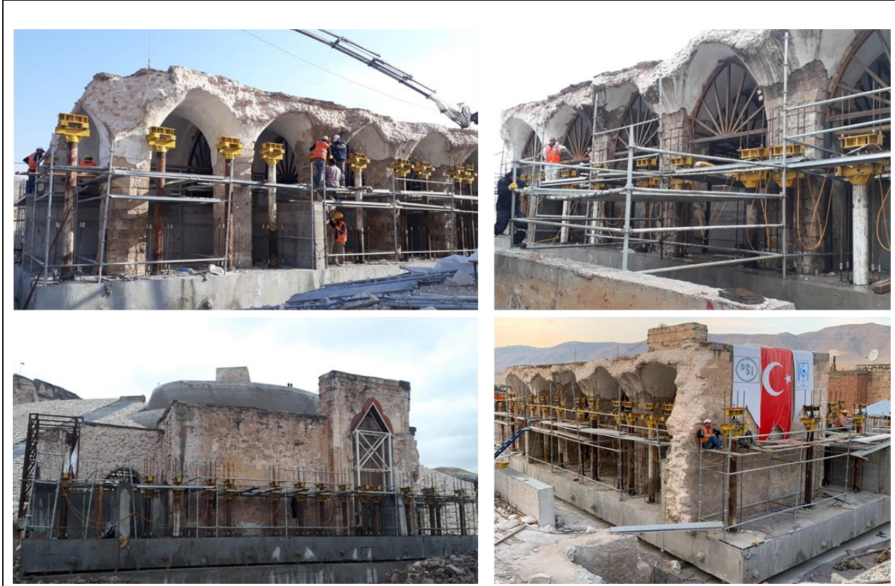
Resim 10. Hasanköy Er Rızk Camii Revaklı Mekân Kütlesi Strüktürel Bütüncül Taşıma Projesi Kaldırma Kriko Sisteminin Kurulması.
