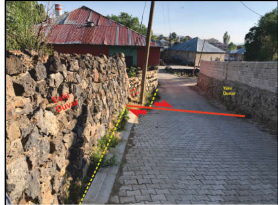
Şekil 13. Çaldıran Yerleşim biriminde 7 No'lu fay kolu üzerinde bir yapı temeli ve bir duvarda 1,5 m sağ yanıl atım (bakış B'ya)
