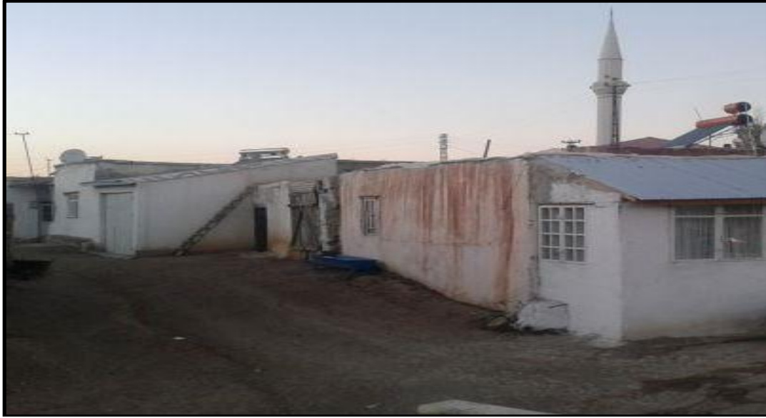
Fotoğraf 3. Araştırma Sahamızda Düz Çatılı Mesken Örneği
