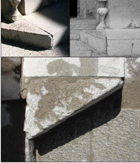
تصویر شماره (11): سنگ شاخص ظهر شرعی مدرسه سلیمانیه (واقع در ظلع جنوب غربی مسجد امام اصفهان)، دوره صفوی منبع تصویر: محمد باقری
