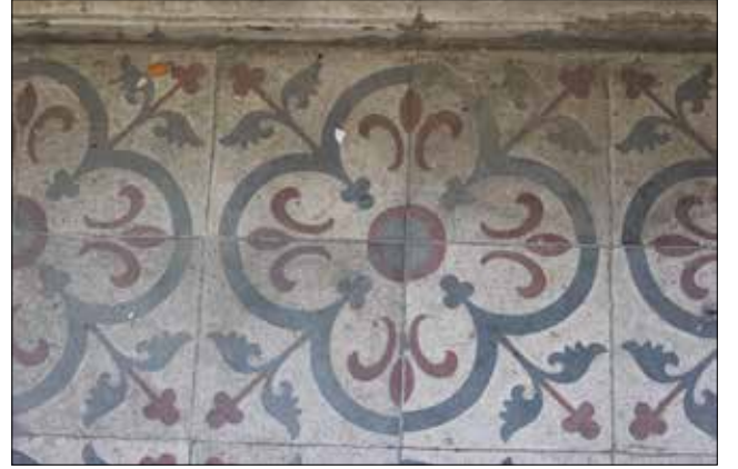
Fotoğraf 10b. Karosiman Döşeme Kaplaması (Havran Belediyesi ve Balıkesir KVKBK Arşivleri). / The original floor tile covering (Archives of Havran Municipality and Balıkesir Conservation Board).
