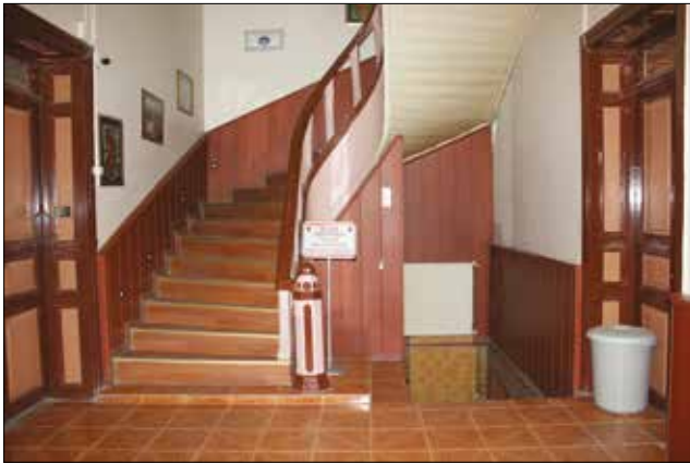
Fotoğraf 11b. Zemindeki sofada yer alan özgün ahşap merdiven / The original timber stair on the ground floor hall.
