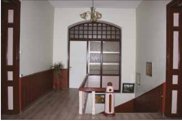
Fotoğraf 13. Birinci katın değiştirilen zemin döşeme kaplaması ve ek birime geçişi sağlayan kapı. / The changed floor coverings of the first floor and the door allows entering to the additional unit.
