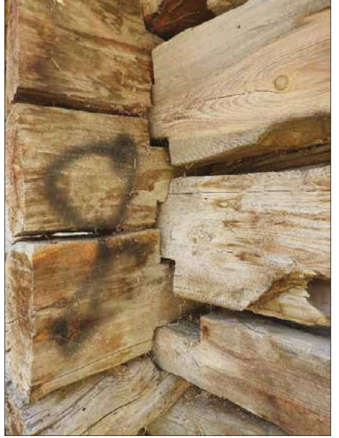
Fotoğraf 15. Kandil duvar (kurt boğazi) / Log wall with Kurt boğazi technique, 2018.
