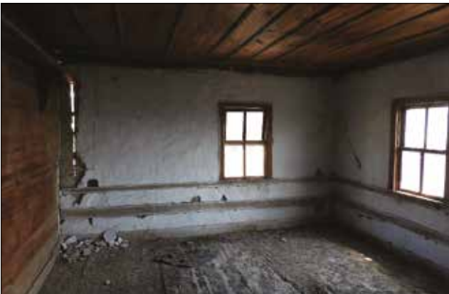
Fotoğraf 36. Uzun Ali'nin Evi, camlı ev görünümü / The view of the camli house of Uzun Ali's House, Yabanlı Village, 2018.
