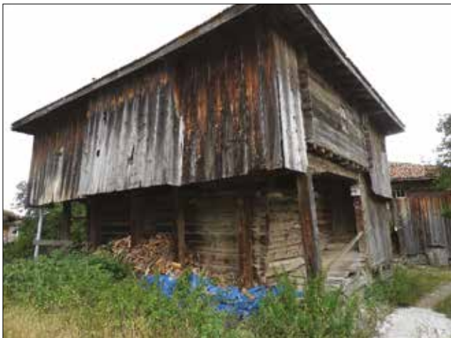
Fotoğraf 54. Hela ve Kiler cephesi, Killik Köyü / Toilet and larder facade, Killik Village, 2018.
