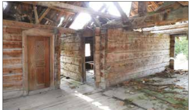
Fotoğraf 40. Kel Süleğin Evi sofa görünümü, Bürüm Köyü / View from the hall, Kel Sülek's House, Bürüm Village, 2018.
