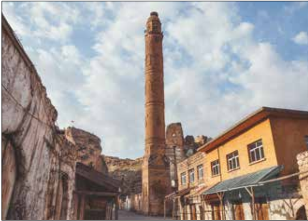
Resim 2c. Hasankeyf Er Rızk Camii Minaresi / Hasankeyf Er Rızk Mosque Minaret
